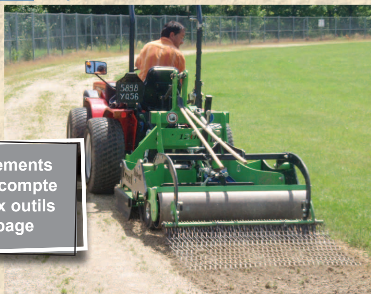
Hersage d'un stabilisé
