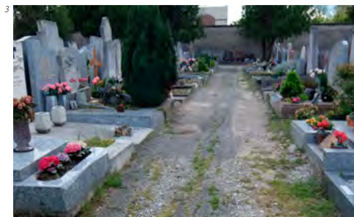
3 - Cimetière de Loyasse à Lyon (69). Cette allée, dont l'enrobé vieillit avec des fissures où poussent des adventices, où creux et bosses gênent la circulation piétonne et créent des flaques après la pluie, sera réhabilitée en ménageant deux bandes enherbées de 50 cm (passage de la tondeuse) le long des sépultures et une bande en béton au centre. © P&C - Sandrine LARRAMENDY 2016
