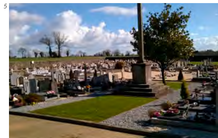
5 - Cimetière d'Ambrières-les-Vallées (53). Dans le cadre du passage au « zéro pesticides », une réfection a été menée : allées piétonnes refaites avec du gravier granit concassé en 10-12 mm et inter-tombes avec du gravier roulé-lavé de couleur clair (issu de la carrière locale de Montreuil Poulay). Pour éviter la pousse de plantes spontanées, un géotextile a été posé. © Emmanuel JAVAUX 2016
