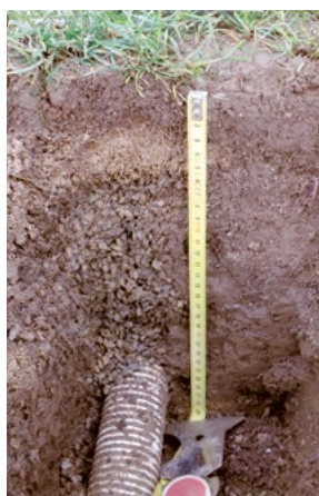
Le sondage du terrain révèle l'existence d'un réseau de drainage superficiel muni de drains. Il permet d'apprécier les dimensions et l'état des tranchées drainantes. ©V. PAILLAT, FREDON BRETAGNE.
