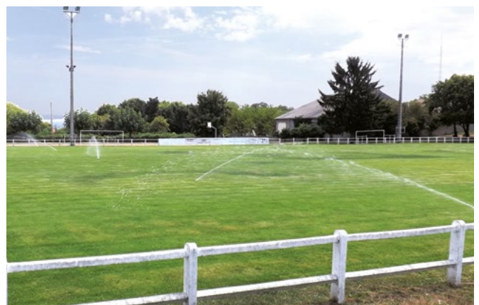
Le manque de pression et de débit dans l'installation est le signe d'un arrosage intégré défectueux. ©F.LUCAS, FREDON AURA
