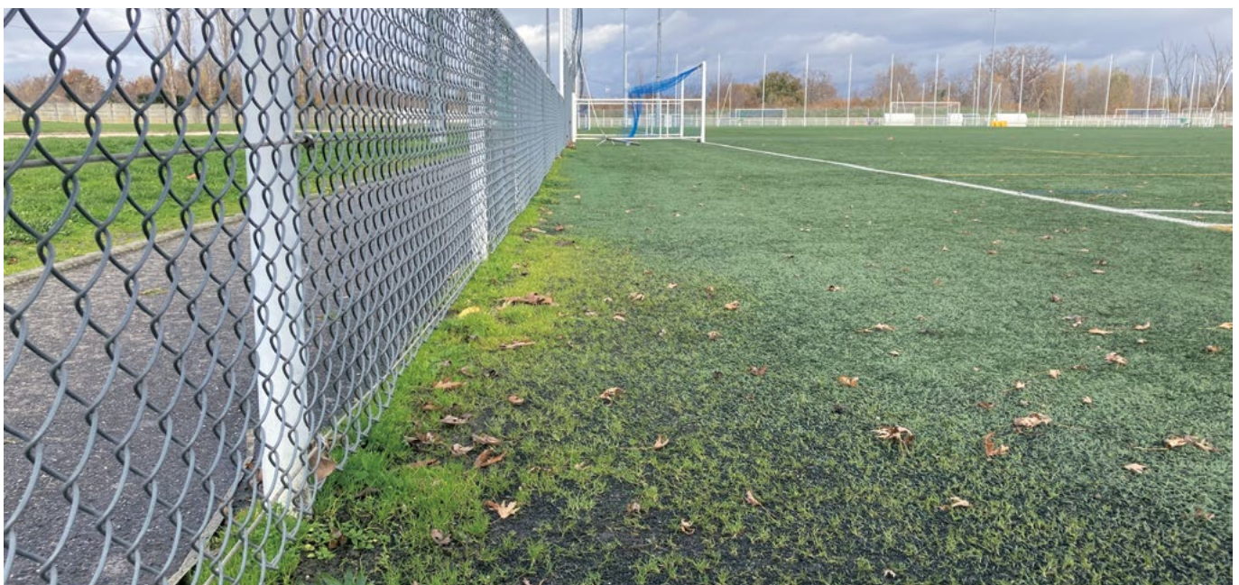
Les terrains en gazon synthétique peuvent être colonisés depuis leurs abords par une flore spontanée. Les opérations de nettoyage et de brossage doivent ainsi rechercher le déblai de la matière organique susceptible de créer des conditions favorables à son développement. ©Ville de Muret (31)
