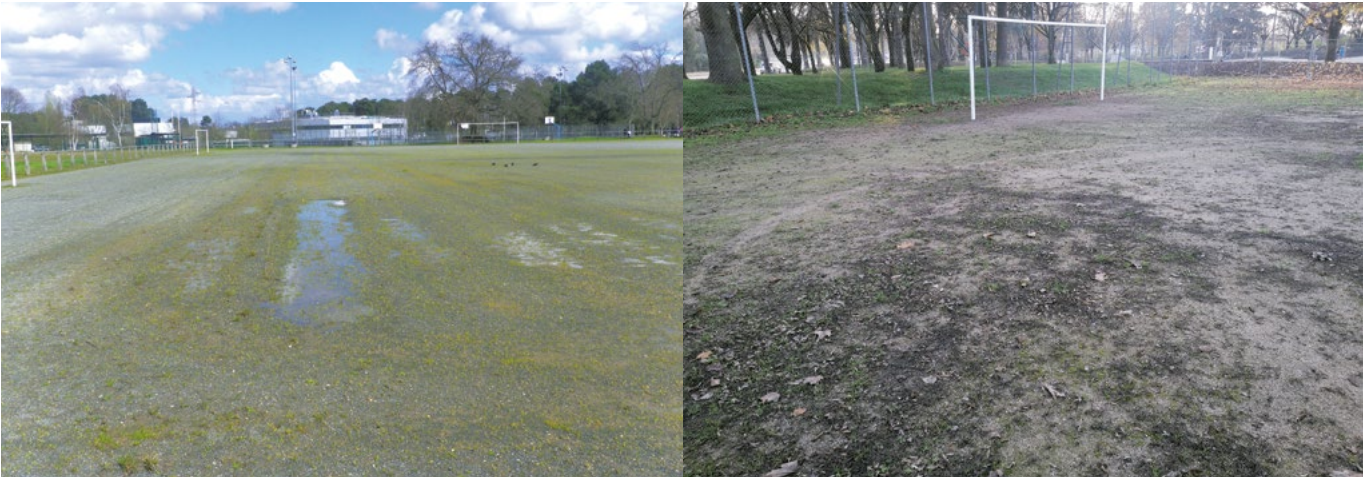
Les abords des terrains en stabilisé peuvent rapidement être colonisés par la flore spontanée. De même, les dépôts de matière organique (feuilles...) en surface, faute d'un entretien avec un équipement adapté, peuvent créer des problèmes de drainage lors d'épisodes pluvieux. ©D. MATHEUX et ©F. LE ROUX, Sport International.
