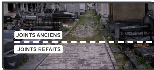
Réfection des joints des pavés pour limiter l'entretien et l'utilisation de produits phytosanitaires
