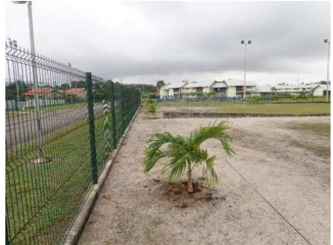
25. Photo : Grillage rigide avec finition béton au boulodrome de Sinnamary
