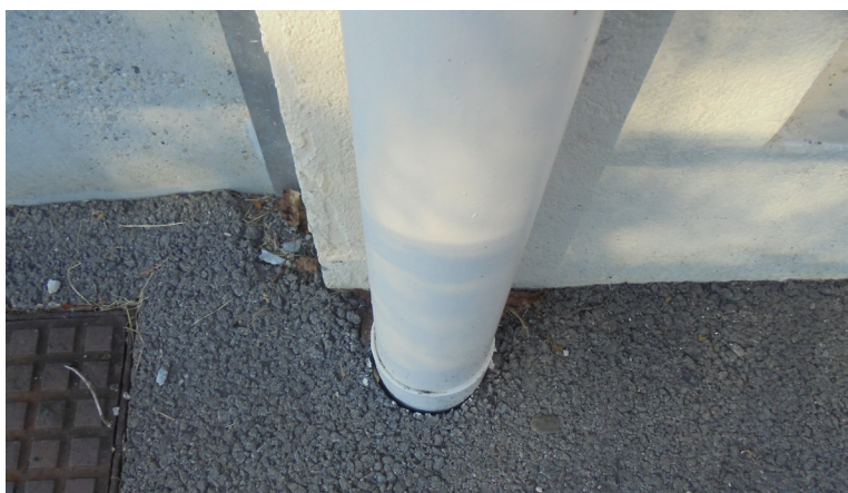
Exemple d'une descente de cheneau hermétique
